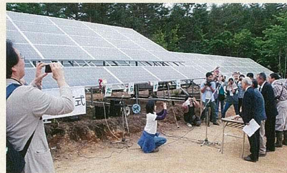
野田村だらすこ太陽光市民共同発電所1号機
