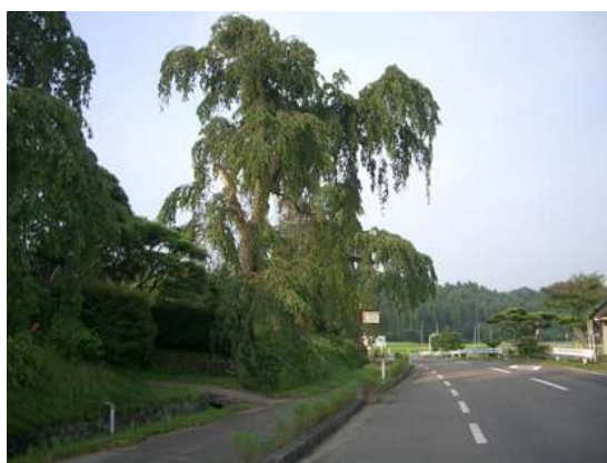
例：主要地方道平泉殿美溪線（管理者：岩手県）
