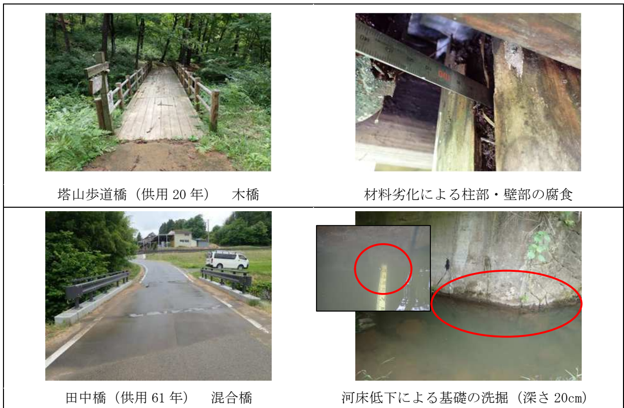
写真-3.1 III判定の橋梁と損傷写真
