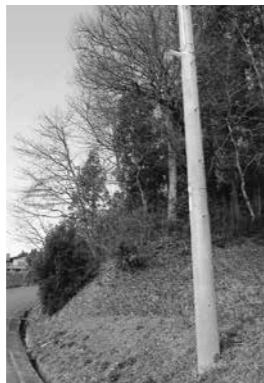
令和4年度は、防犯灯を15基設置
