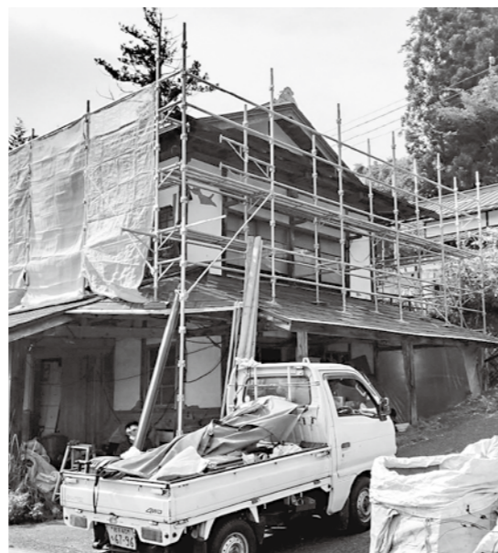
雪害による屋根の改修工事
