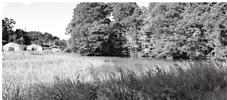
ため池の繁茂状況
