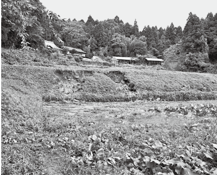
台風16号による法面崩落
