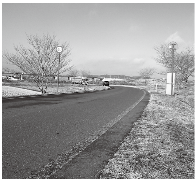
防災マップにないのに冠水(坂下線)
