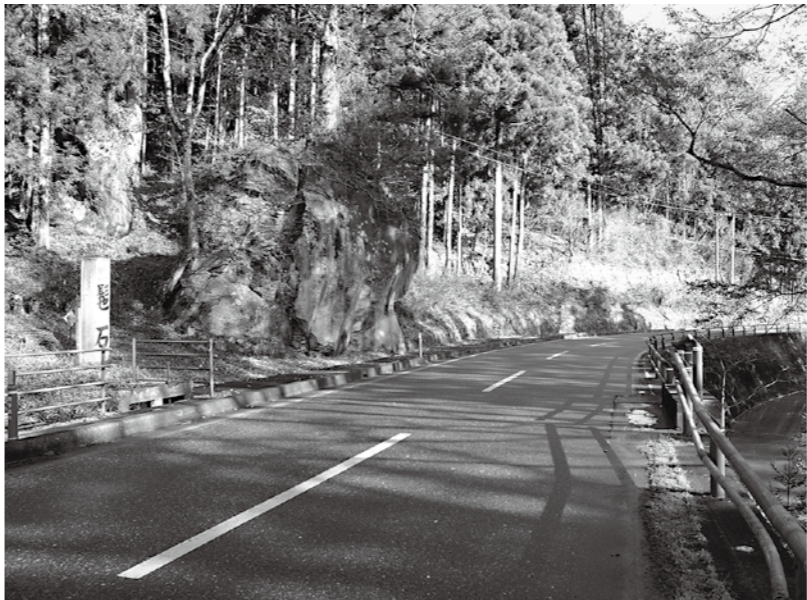
改良が望まれる県道平泉蔵美深線髭石付近
