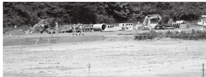
建設工事が進むスマートインターチェンジ予定地
